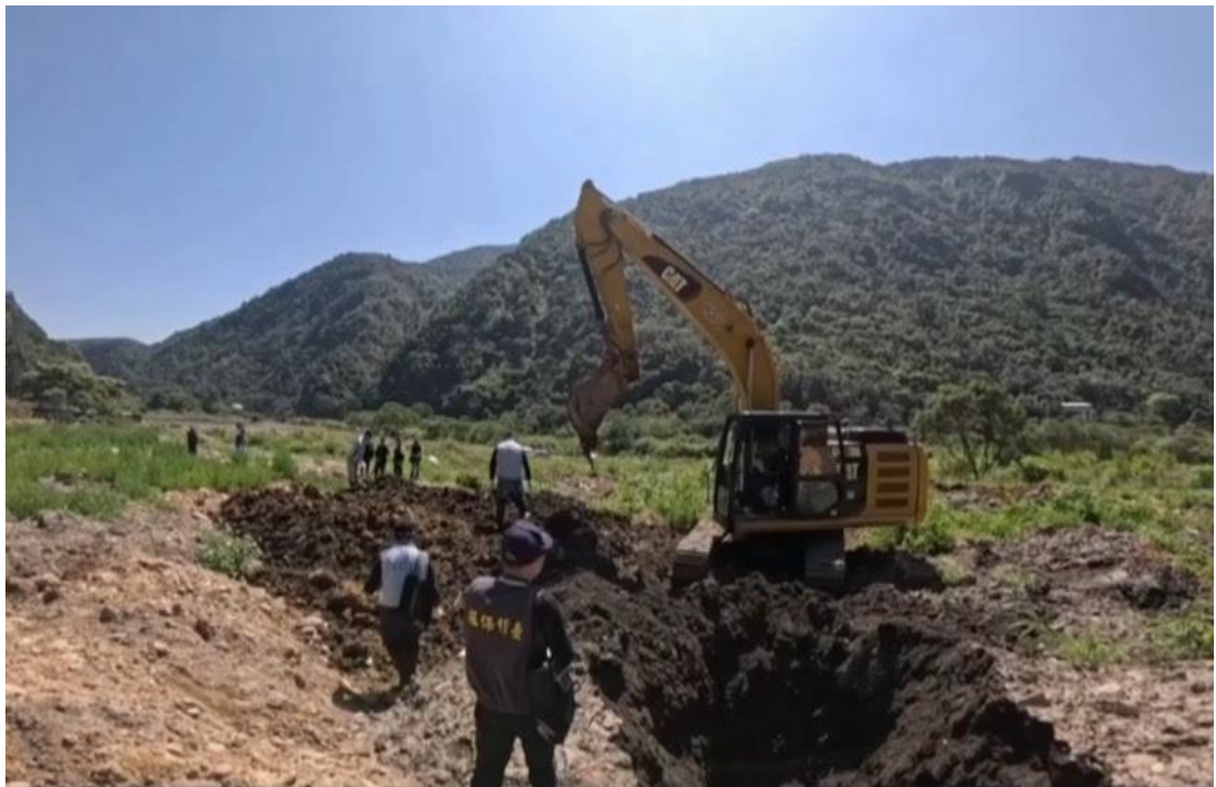
（本案開挖調査）
